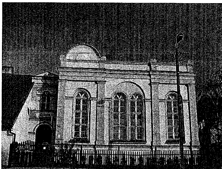
Barczewo, budynek dawnej synagogi
