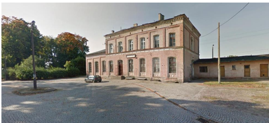
Rys.3 Dworzec kolejowy w Barczewie
