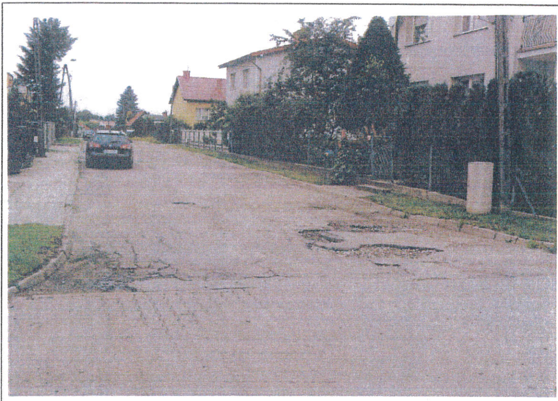
ul. E. Orzeszkowej w Barczewie - połączenie z ul. Nowodworcową
