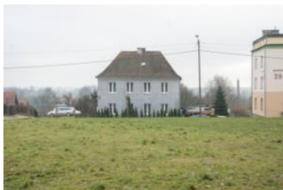
ryc. 5. Widok na działkę i zabudowę przy ulicy Warminskiej źródło: zdjęcia wykonane podczas wizji lokalnej
