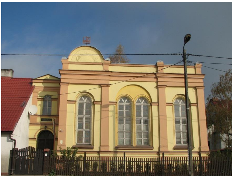
Barczewo, budynek dawnej synagogi
