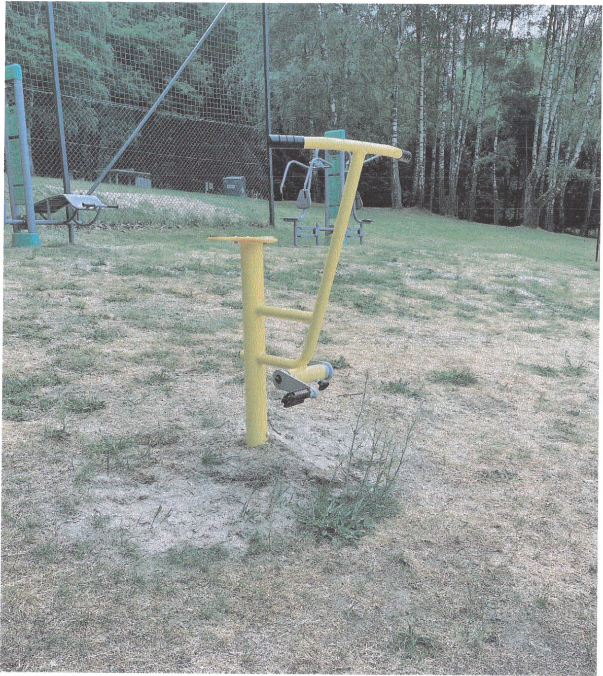
- montaż, roweru treningowego, stacjonarnego.
